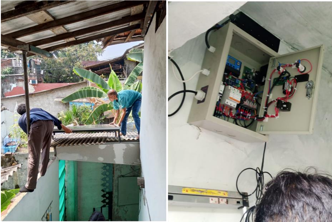
Gambar 5. Pemasangan dan Uji PLTS
